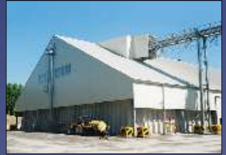
Италия - Производственное здание
